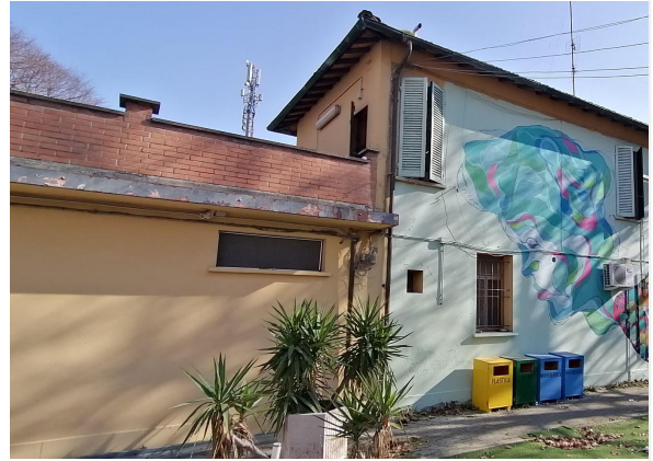
magazzini e camere (la casa del custode - notare parte ad 1 piano aggiunta successivamente)
