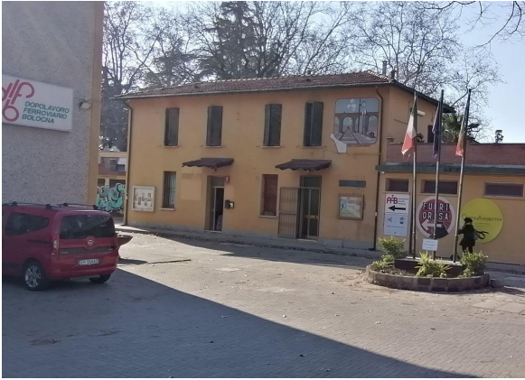
magazzini e camere (la casa del custode - notare parte ad 1 piano aggiunta successivamente)
