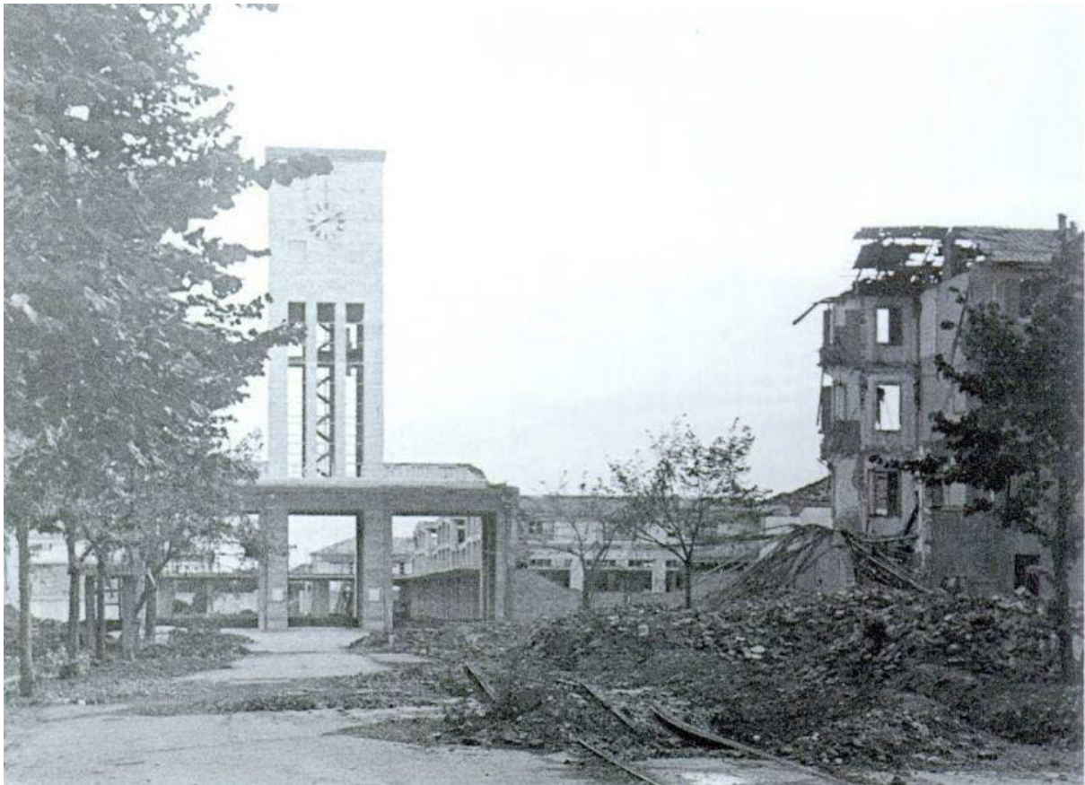
Prospetto EST e principale dell'ex Mercato Ortofrutticolo Centrale – Post bombardamenti
