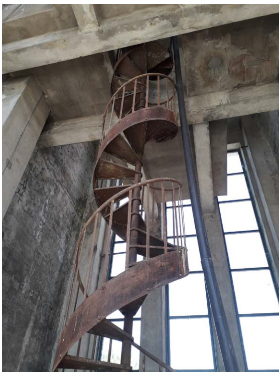
Interno piano secondo della torre piezometrica, scala metallica
