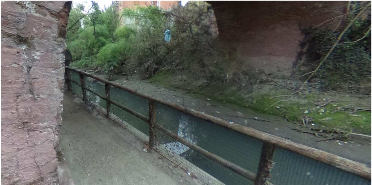
Stato di fatto – Passaggio esistente sotto al Ponte del Vignola
