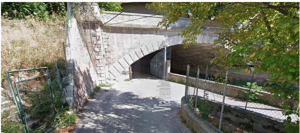
Stato di fatto - Sottopasso ferrovia Bovi Campeggi – Parco di Villa Angeletti
