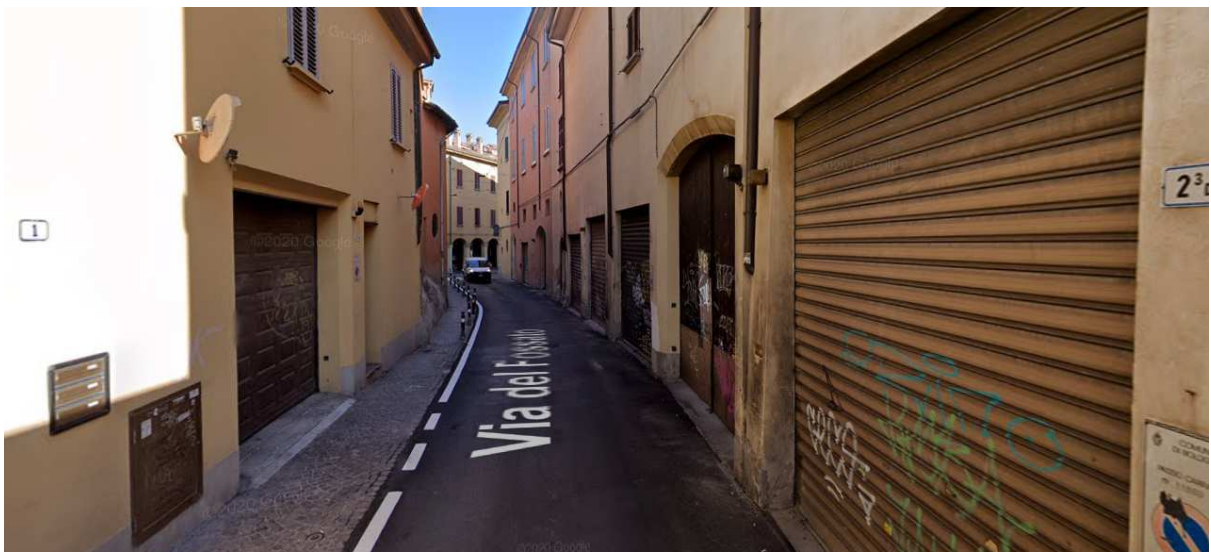
Stato di fatto – via del Fossato
