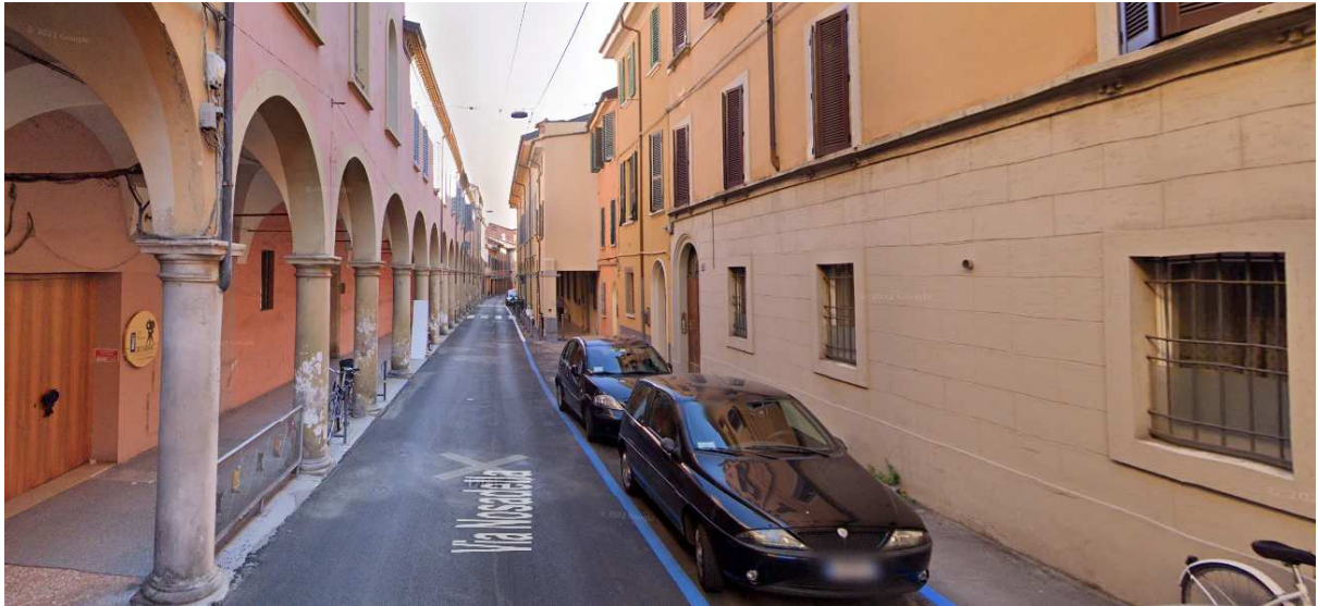
Stato di fatto – via Nosadella
