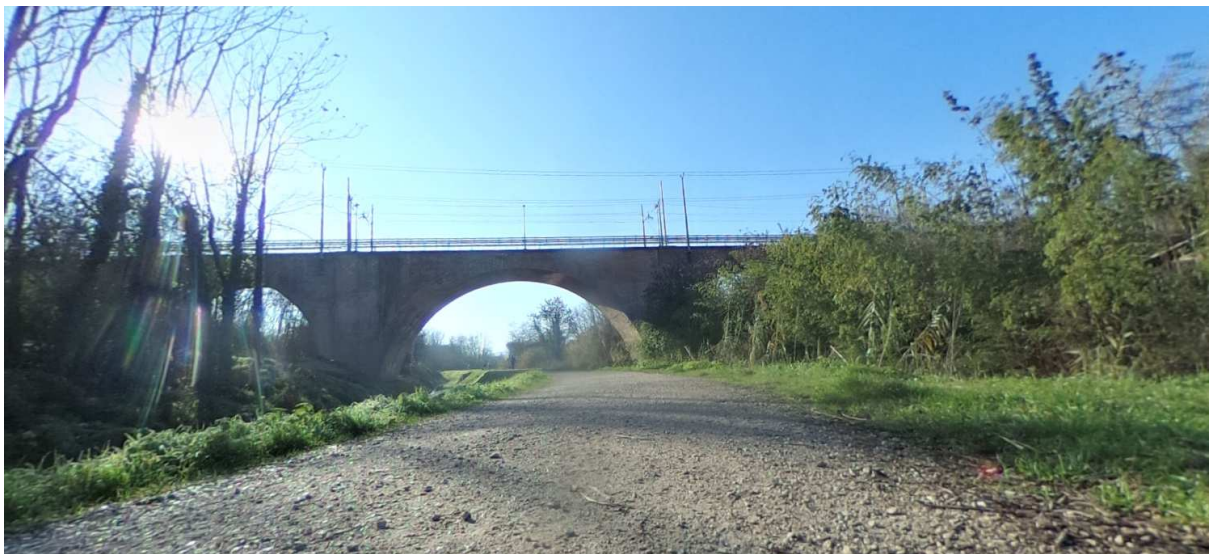
Stato di fatto – Sottopasso ferrovia
