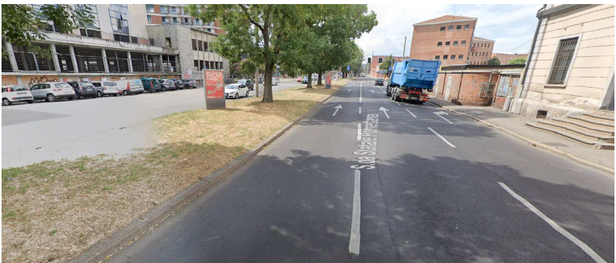
Stato di fatto - Via Pietramellara lato ovest
