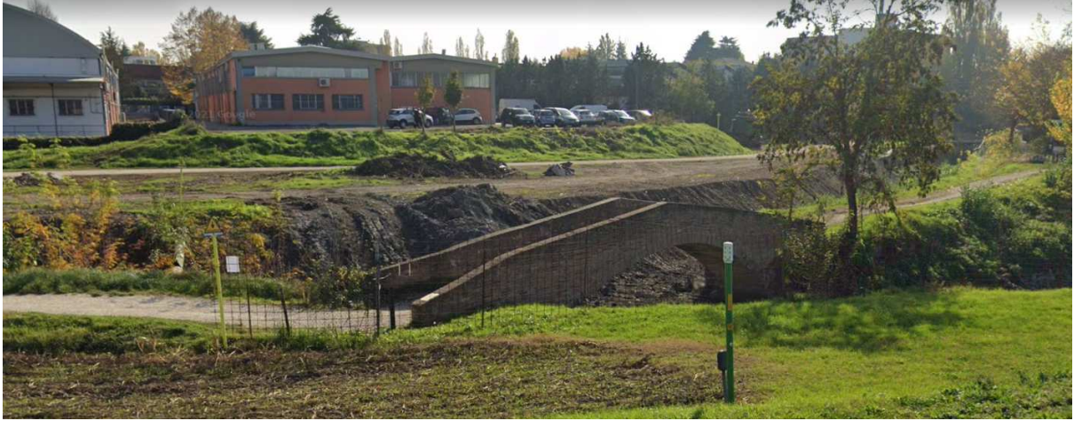
Stato di fatto – Ponte della Bionda
