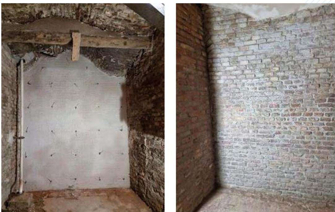
Interventi di consolidamento con intonaci armati o mediante ristillatura dei giunti
